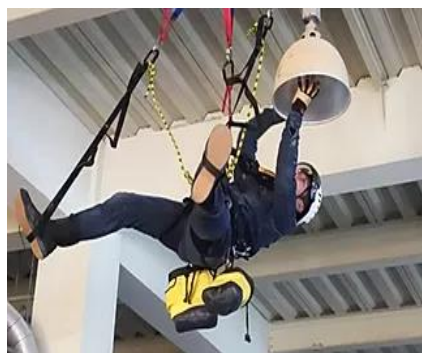
RAEE工法による高所電気工事
